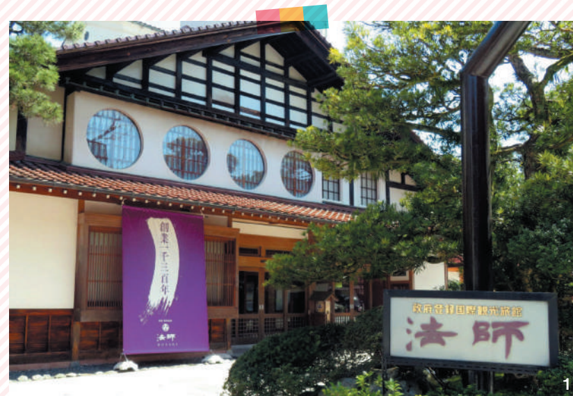
1.国の登録有形文化財に登録された玄関棟 2.旬のもの、地のものを取り入れた和会席料理 3.青石の笏谷石を使った開放的な露天風呂
